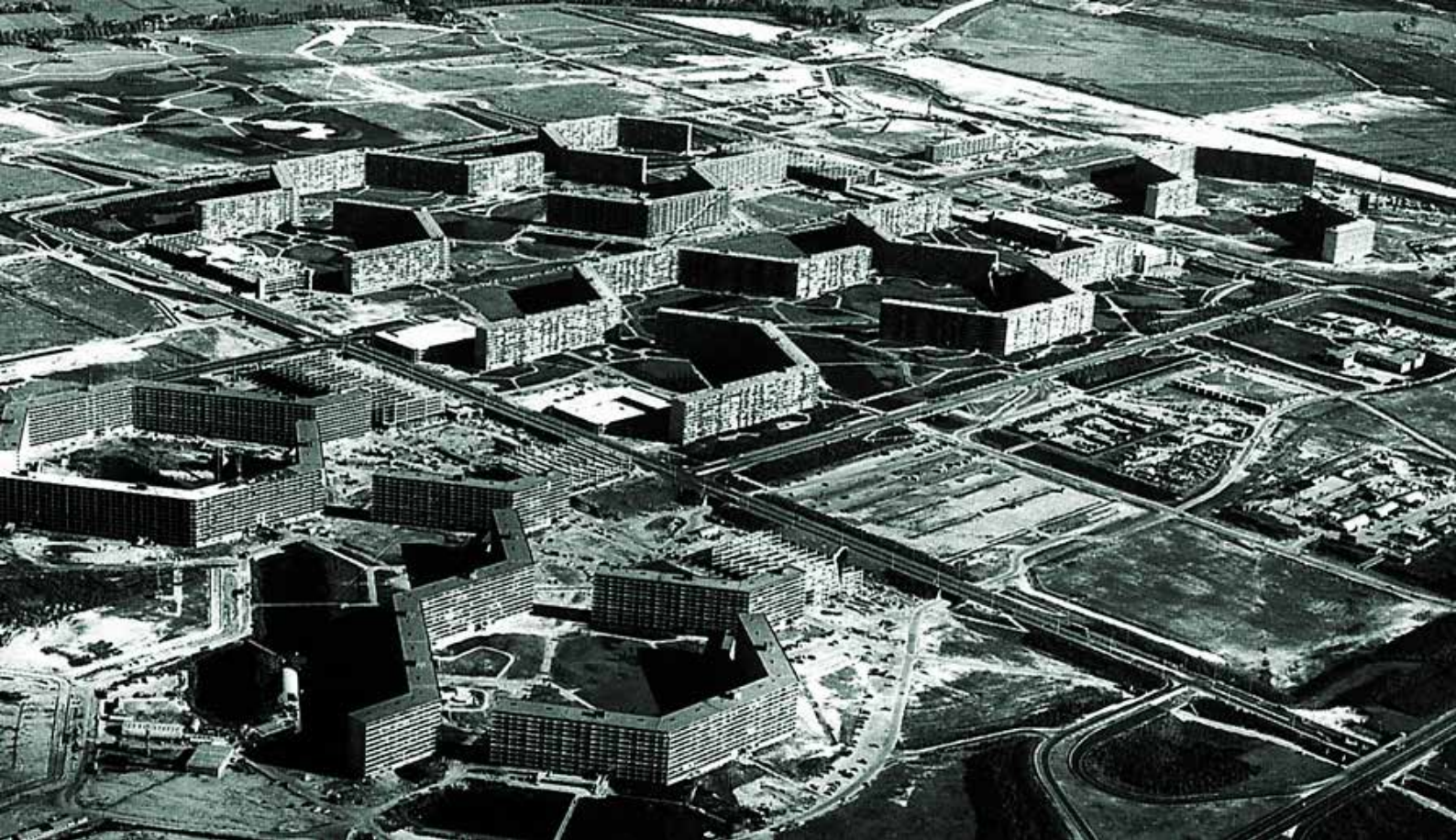
33. Vista aérea de Bijlmermeer durante su construcción. (Mingle 2018)
