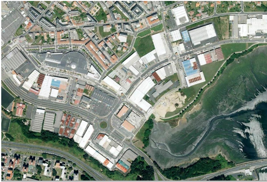
Figura 6.- Vista aérea del polígono industrial de A Gándara
