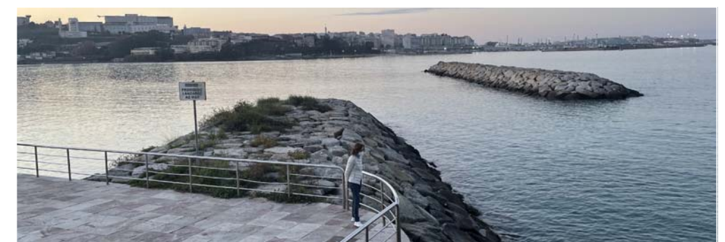
Vista desde paseo DIQUES-PLATAFORMA
