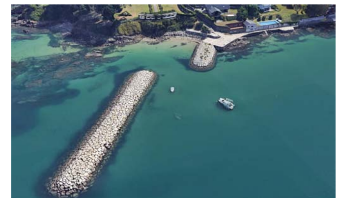
Vista aérea frontal DIQUES-PLATAFORMA
