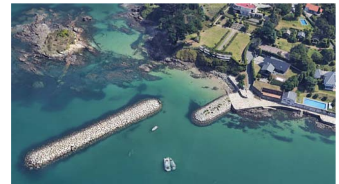
Vista aérea DIQUES-PLATAFORMA PASEO
