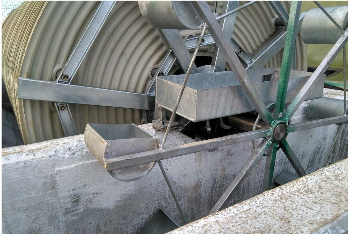
Figura 7: Cangilones para regular caudal de entrada en una planta de Xunqueiro (Oleiros).
