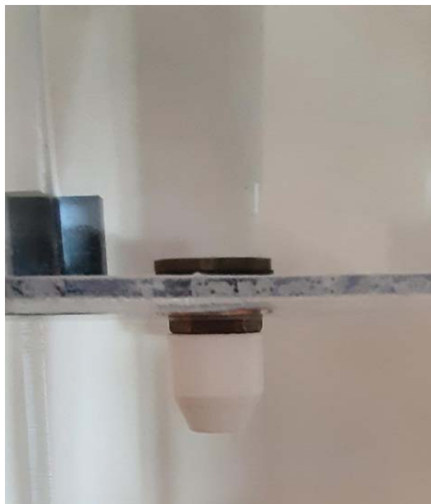
Figura 8.75 – Montaje desagüe fijo
