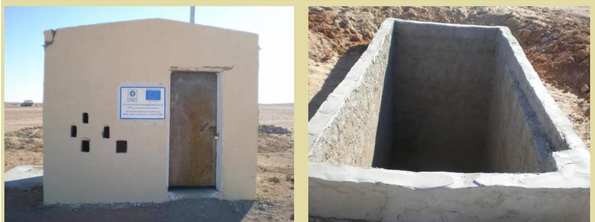
*Figura 3.3. Una de las cuatro incineradoras construidas en el hospital general de la wilaya por Médicos del Mundo Grecia y financiada por ECHO (izquierda) y foso utilizado para depositar las cenizas (derecha).*
