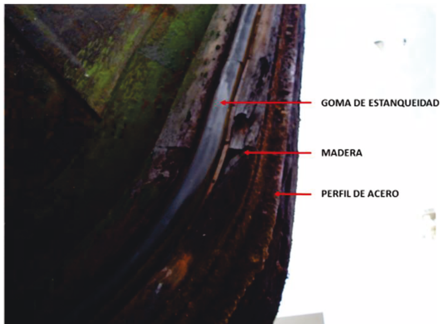
Ilustración 23. Perfil del Barco-Puerta.
