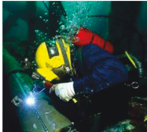
Ilustración 6. Soldadura húmeda. Fuente: jmbuzos@arnet.com
