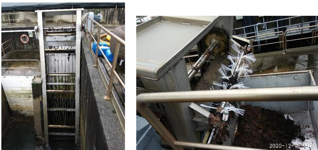
Ilustración 6: Izquierda pozo de bombas con extractor de algas, derecha colector de algas
