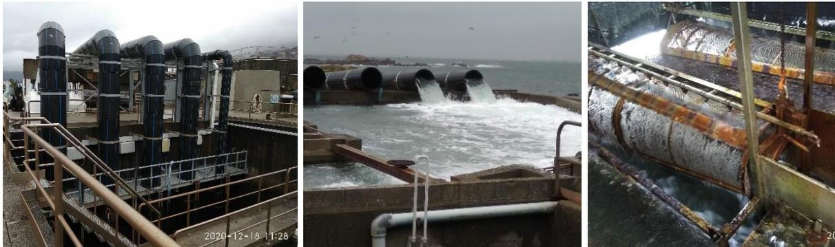
Ilustración 7: de izda. a dcha.: bombas y tuberías, tanque de cabecera y filtro rotatorio de 1cm
