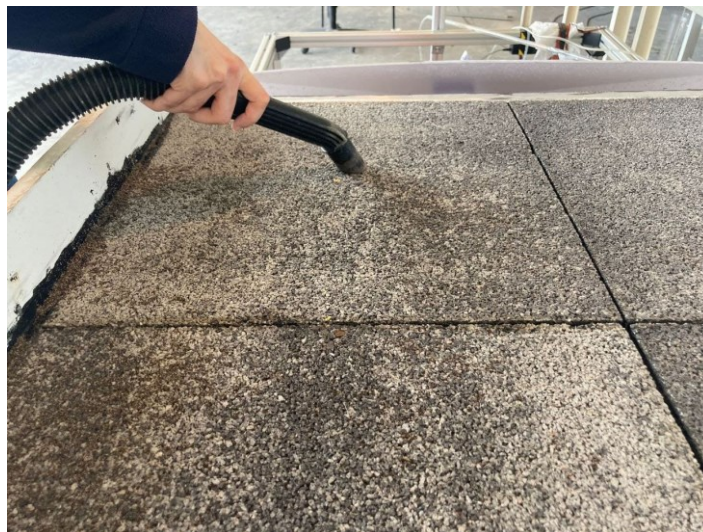
Figura 21. Proceso de aspiración de sedimentos
