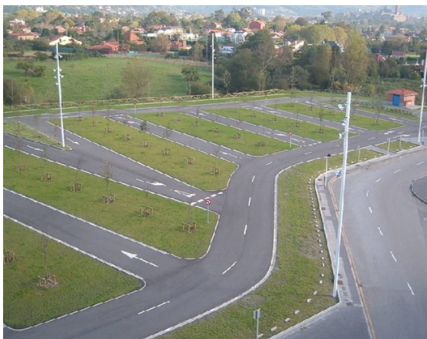
Figura 5. Pavimentos permeables en el parque de La Guía (Castro-Fresno et al., 2013)
