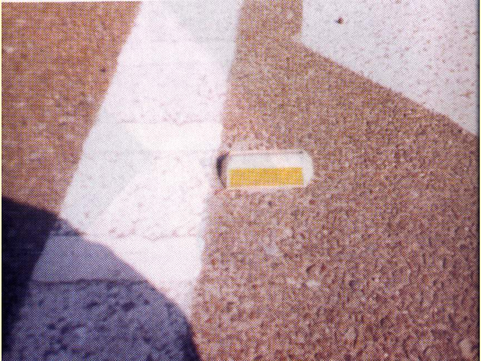
Captafaro sobre pavimento y pintura de resalto
