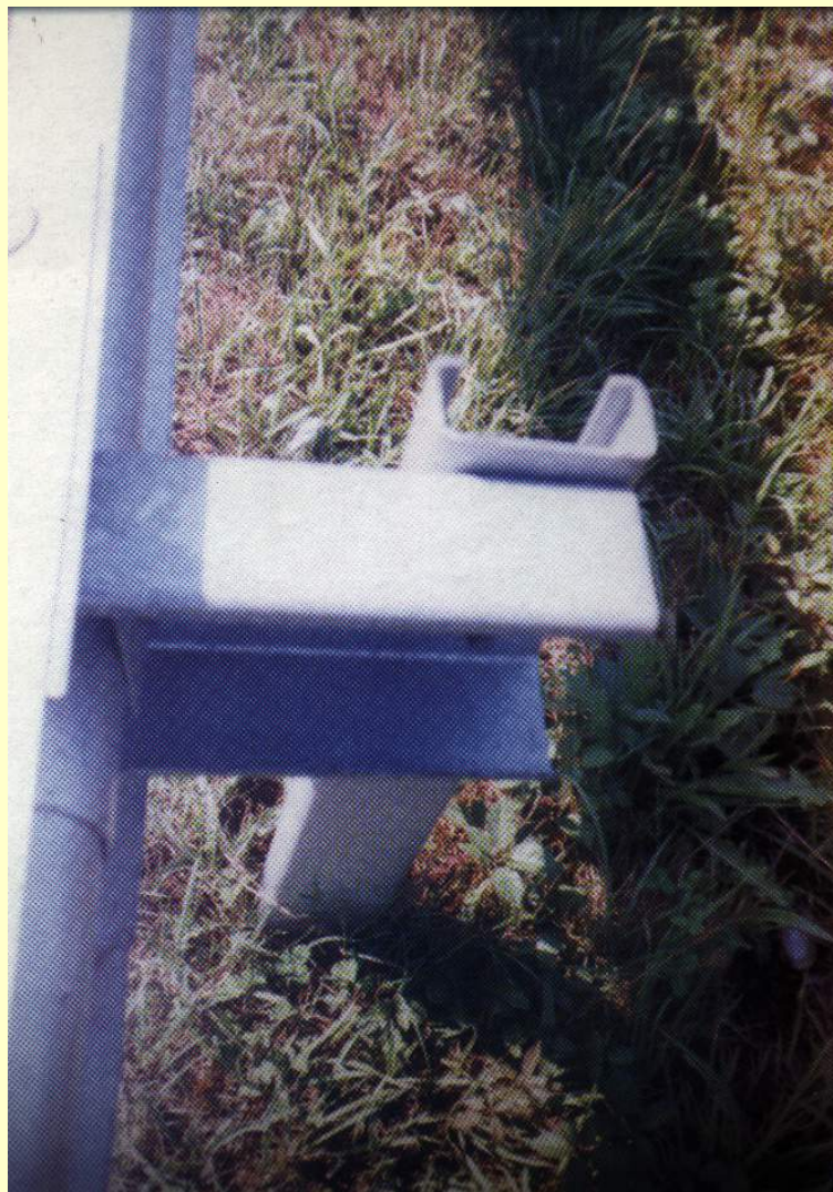
Nuevo Poste “C” y separador de barrera metálica
