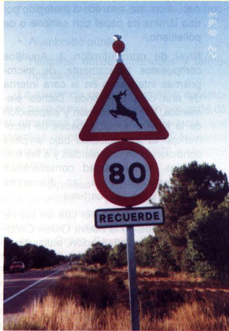
Señal vertical reforzada con baliza luminosa
