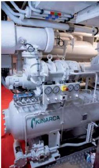
**Ilustración 11: Compresores de frío para las bodegas**
