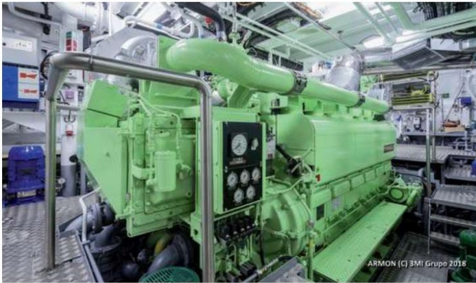
► Sala de máquinas del arrastrero con el motor principal de seis cilindros.
