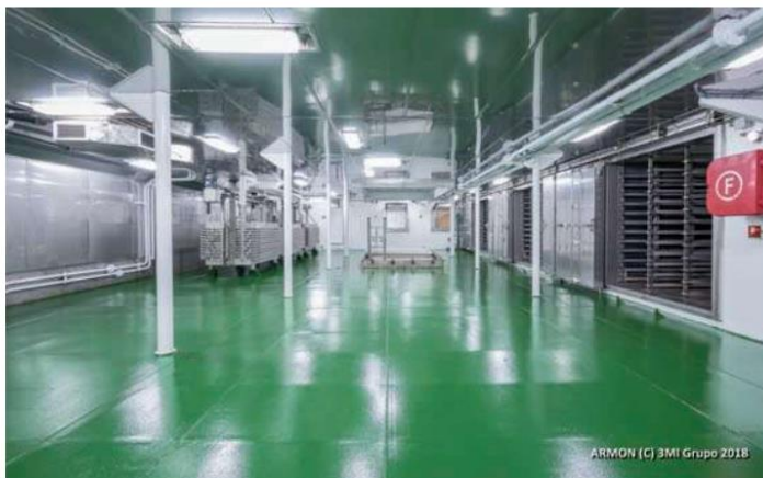
► Equipos de frío a ambos lados de la amplia bodega de carga del arrstrero.
