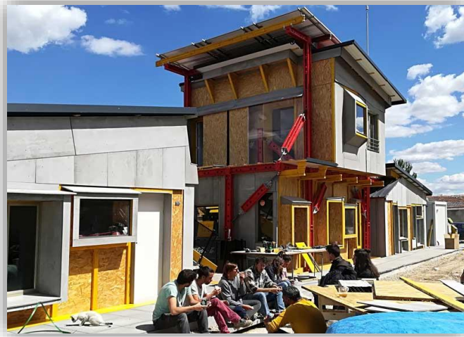
Imagen 2: Construcción en Cañada Real
