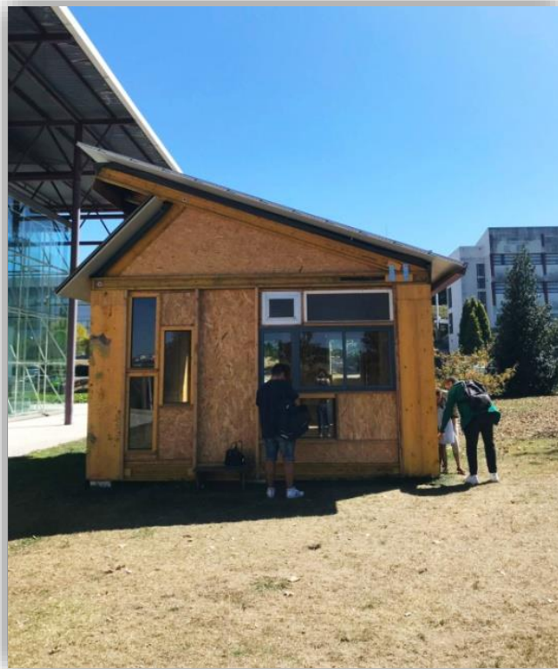
Imagen 28: Acabado final fachada trasera
