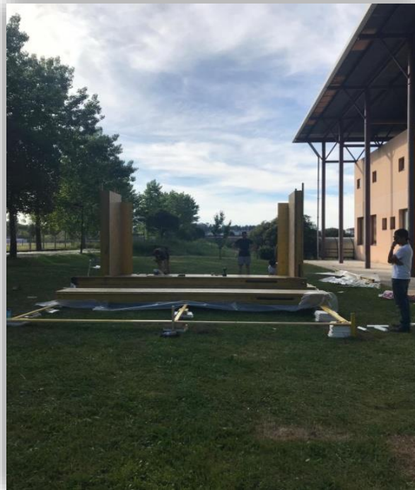
Imagen 20: Montaje de forjado y paredes.
