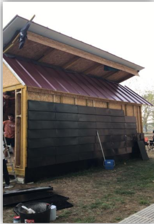
Imagen 34: Carpintería en fachada lateral derecha y cubierta II.
