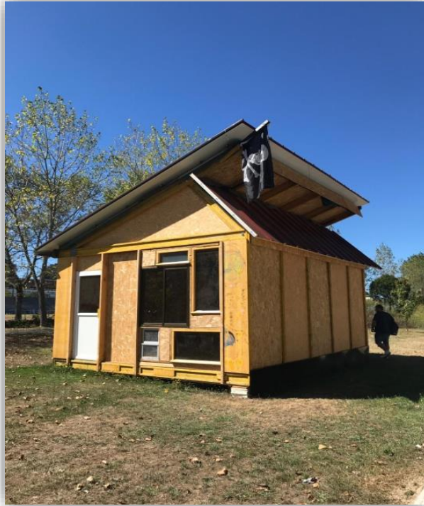
Imagen 27: Acabado final fachada delantera
