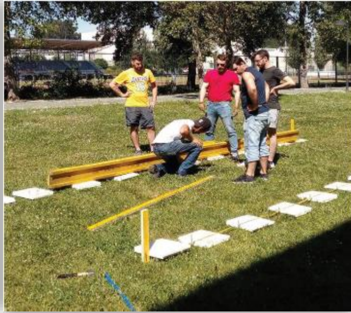
Imagen 19: Nivelación del suelo.
