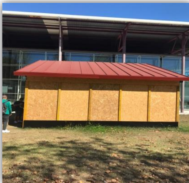
Imagen 35: Carpintería en fachada lateral izquierda y cubierta I.
