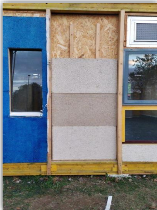
Imagen 37: Carpintería en paredes ventana I.
