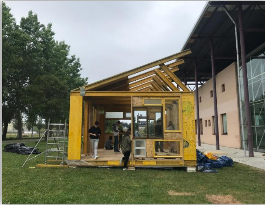
Imagen 23: Montaje de cerchas y levantamiento de la cubierta.
