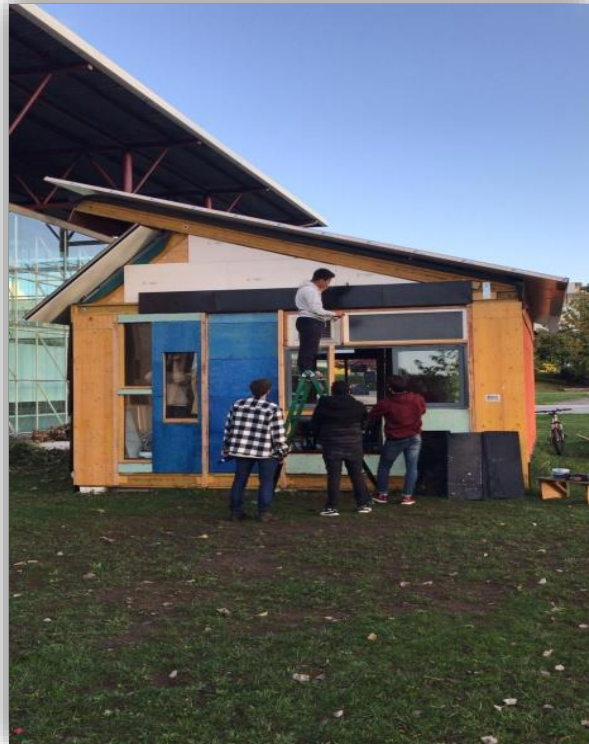
Imagen 38: Carpintería en paredes ventana II.
