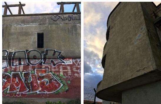
FICHA B.03: DESPRENDIMIENTOS DEL MORTERO (POR PÉRDIDA DE ADHERENCIA POR ELEMENTOS INFILTRADOS)
