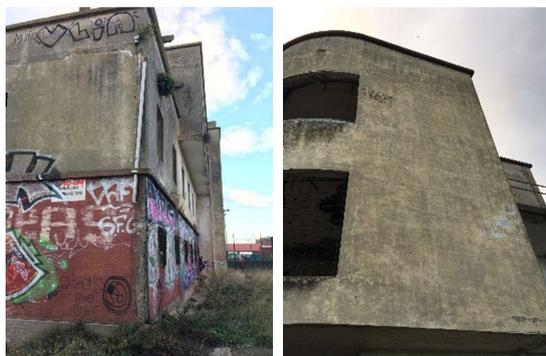
FICHA B.02: DESPRENDIMIENTOS DEL MORTERO (POR PÉRDIDA DE ADHERENCIA POR MOVIMIENTOS DEL SOPORTE)
