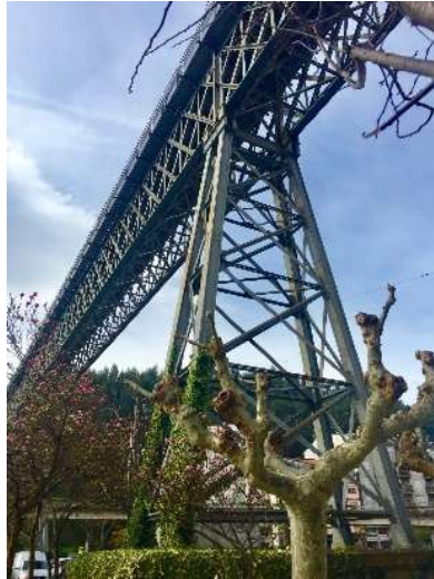
Figura 18. Puente de Redondela (Extraído de https://www.guiategalicia.com/redondela-puente-metalico/ el 22/10/2020).
