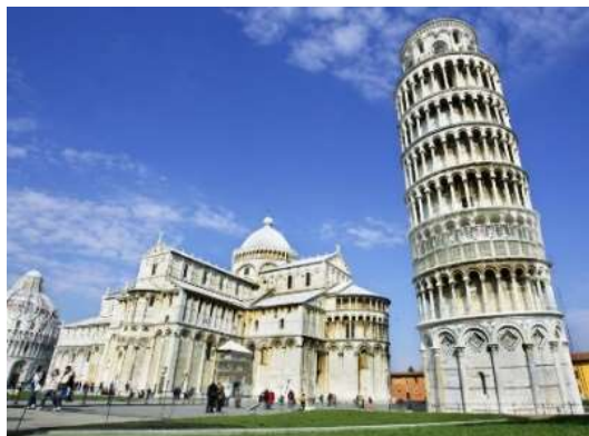
Figura 7. Torre inclinada de Pisa (Extraído de https://www.telemundo.com/lifestyle/educacion/porque-la-torre-inclinada-de-pisa-es-capaz-de-resistir-potentes-terremotos-tmna2778528 el 22/10/2020).
