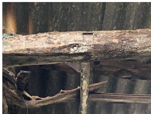
3 Detalle apoyo de vigueta sobre viga de castaño.
