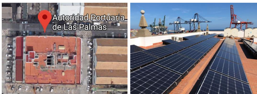
Figura 29. Vista aérea actual, ofrecida por Google Maps en agosto 2019, del tejado de la Autoridad Portuaria de Las Palmas de Gran Canaria, se observa antes de la instalación de los paneles solares. En el lado derecho se observa la cubierta del tejado cubierta con paneles fotovoltaicos tras su reciente instalación en el mes de marzo de 2019.
