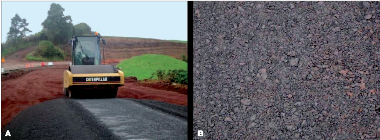
Figura 2. Tramo experimental de ensayo con capa de base granular no tratada de 0,20 m de espesor sobre explanada de lapilli basáltico.
