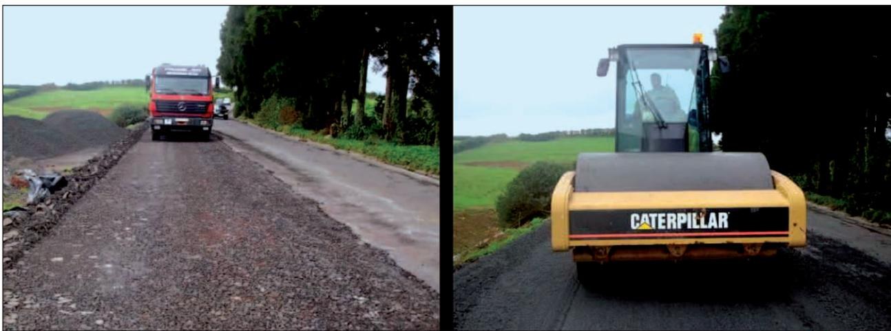
Figura 3. Tramo experimental de ensayo con capa de base granular no tratada de 0,20 m de espesor sobre pavimento existente previamente escarificado y recompactado.
