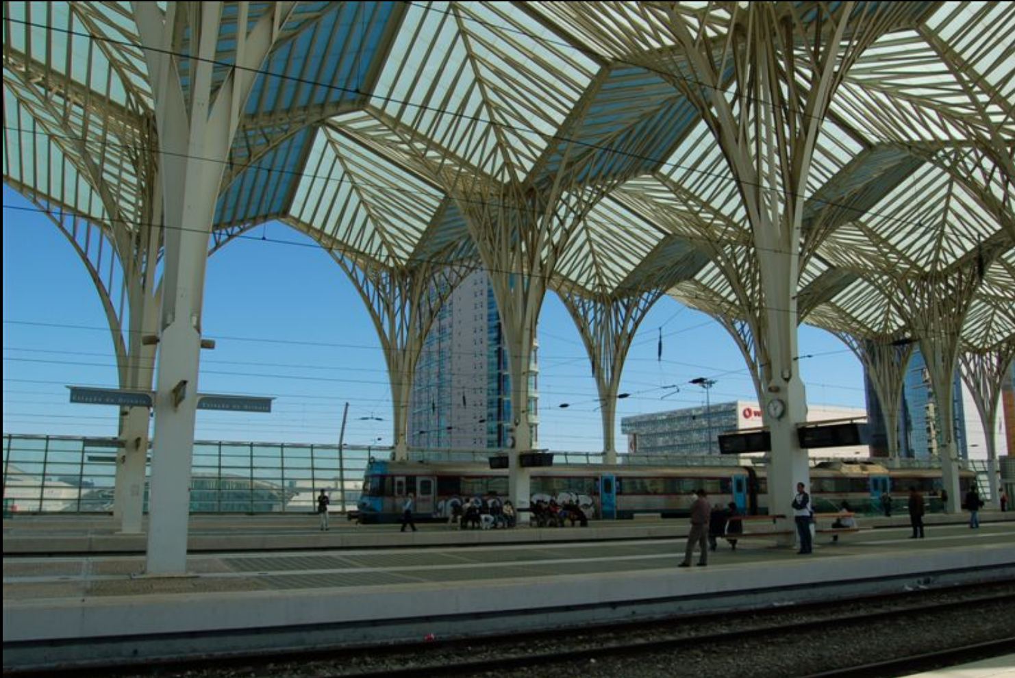
Estación de Oriente, est. ferroviaria_Lisboa, Portugal
