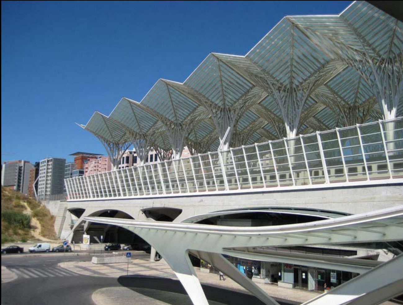
Estación de Oriente, est. ferroviaria_Lisboa, Portugal
