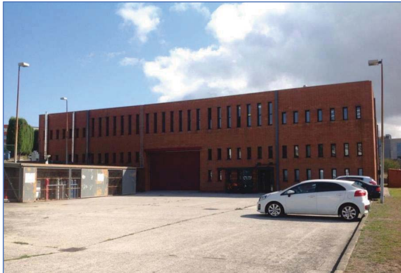
Ilustración 1: Fachada del LCG 6
