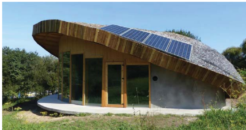
Figura 13. Módulo experimental del proyecto biovalvo, construido empleando hormigones y morteros de concha de mejillón, así como concha en bruto
