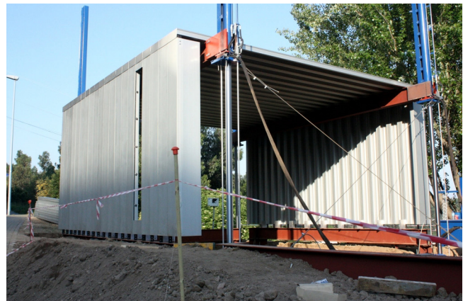
Figura 15. Colocación de los paneles de fachada.
