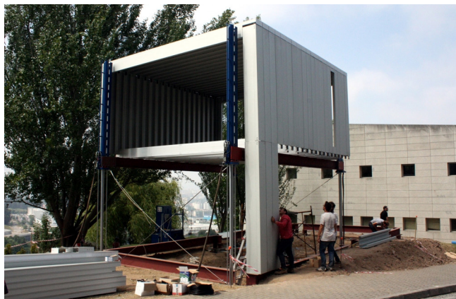
Figura 17. Construcción de la planta inferior.
