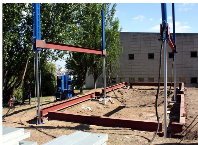
Figura 12. Construcción de la base de apoyo.
