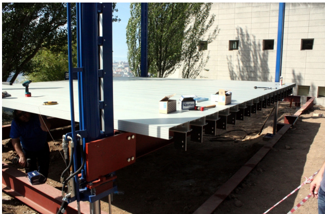
Figura 13. Planta de cubierta sobre gatos para su izado.
