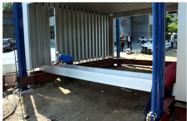
Figura 16. Construcción del suelo de la planta superior.
