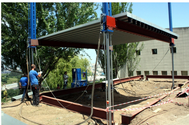
Figura 14. Izado de la cubierta.
