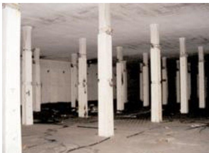
Img. 50: Estado interior de la nave antes de la rehabilitación.
