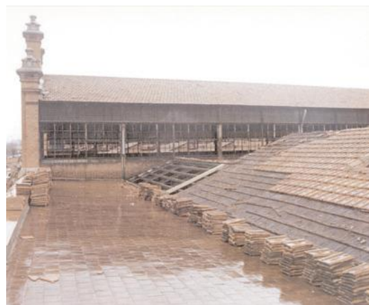
Img. 23: Estado de la cubierta en 1997
