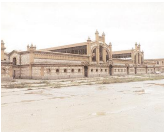
Img. 24: Estado de la fachada en 1997
