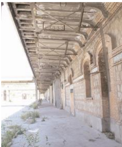
Img. 51: Estado de la marquesina.
