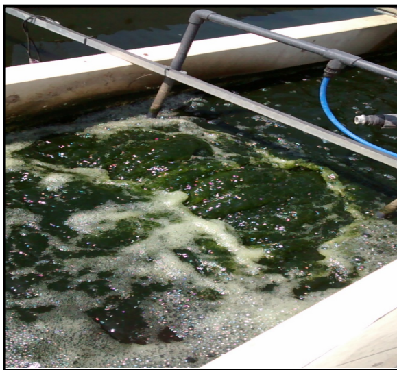
Figura 2. Detalle del foso del reactor
