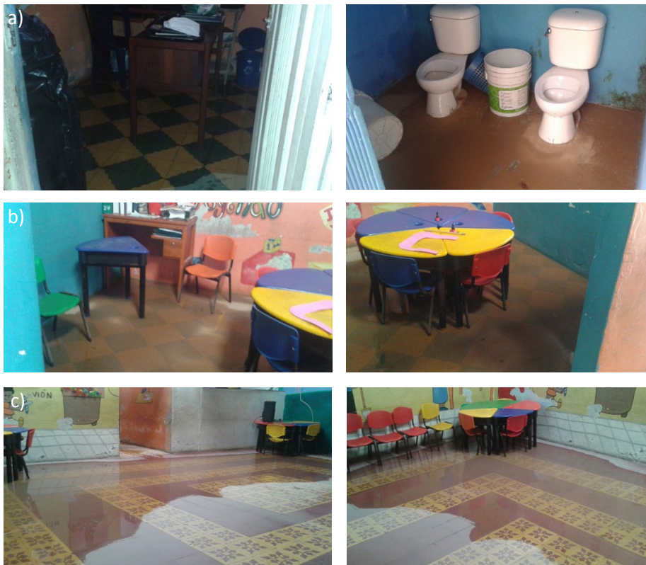
Figura 1. Estado infraestructura tras fuertes precipitaciones. a) Izquierda: despacho de dirección. Derecha: baños alumnos. b) Aulas primaria y preescolar. c) Aula multiusos.
