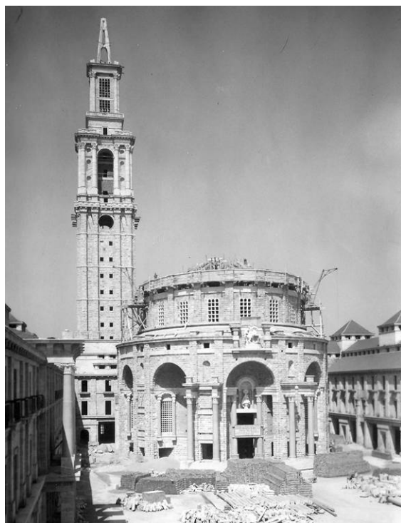
7. Disposición del entramado para conformación del anillo perimetral en la zona de entrega de los arcos y cimbrado de éstos.
