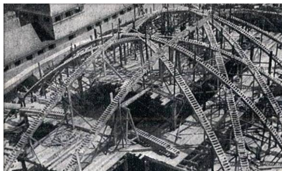
7. Disposición del entramado para conformación del anillo perimetral en la zona de entrega de los arcos y cimbrado de éstos.
