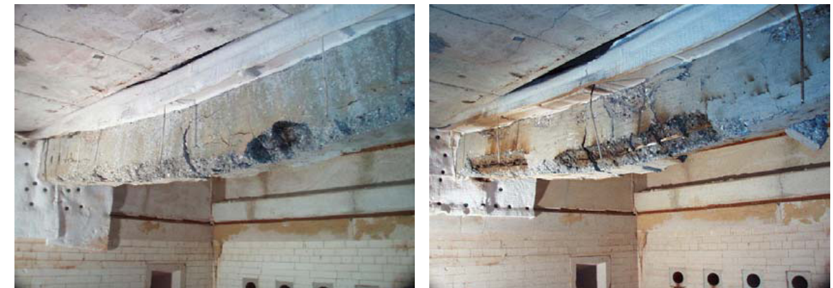
Dos modos de fallo en secciones rectangulares (vigas) sometidas a un test de incendio.
