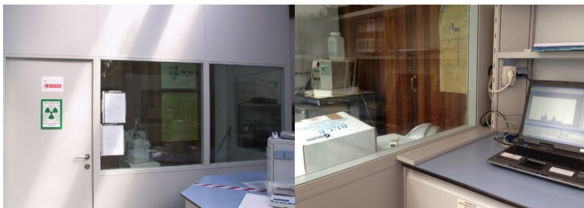
Figura IV-6. Instalación radiactiva, en su interior se encuentra el sistema SMPS
