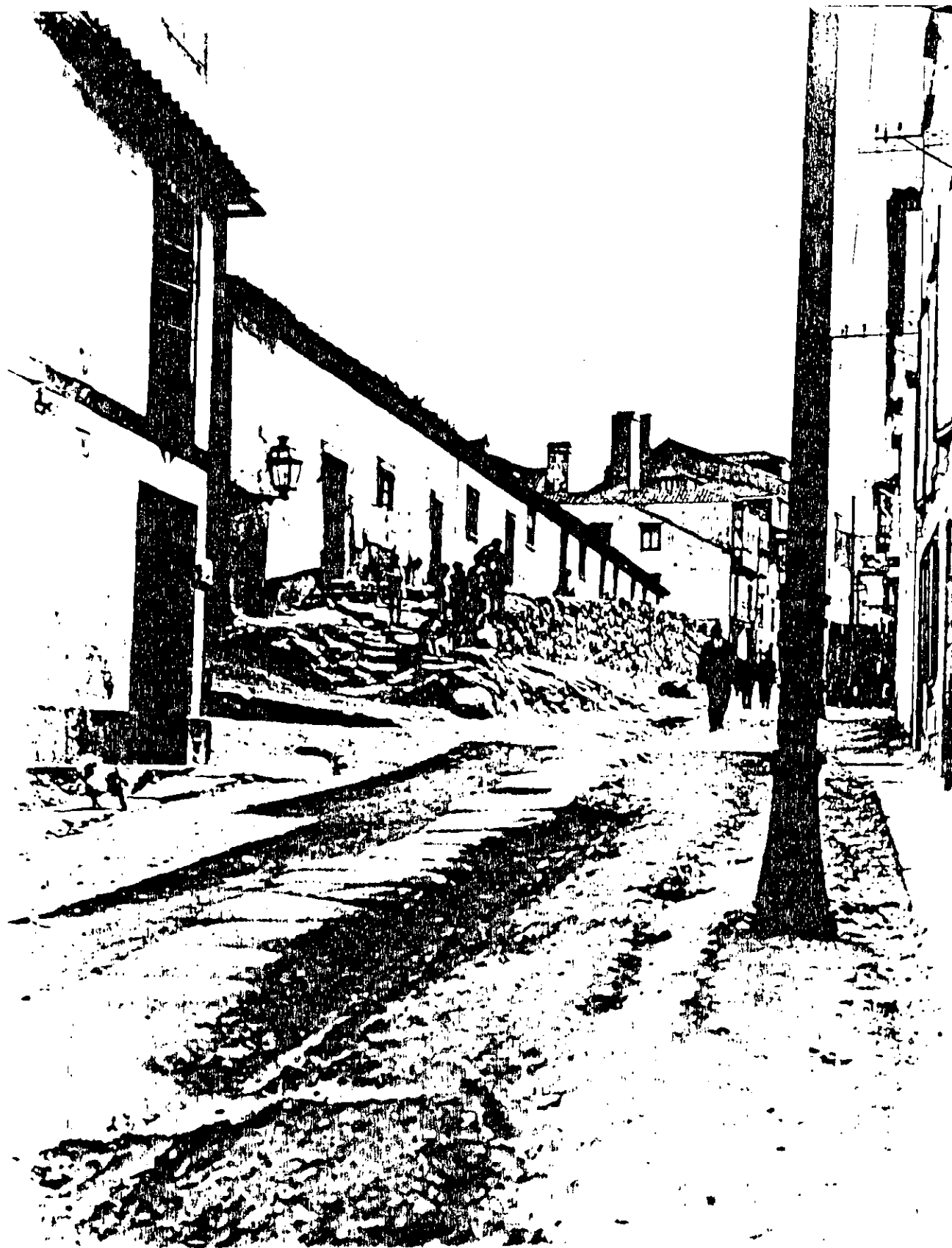
V.I. A RUA DO HOSPITAL
