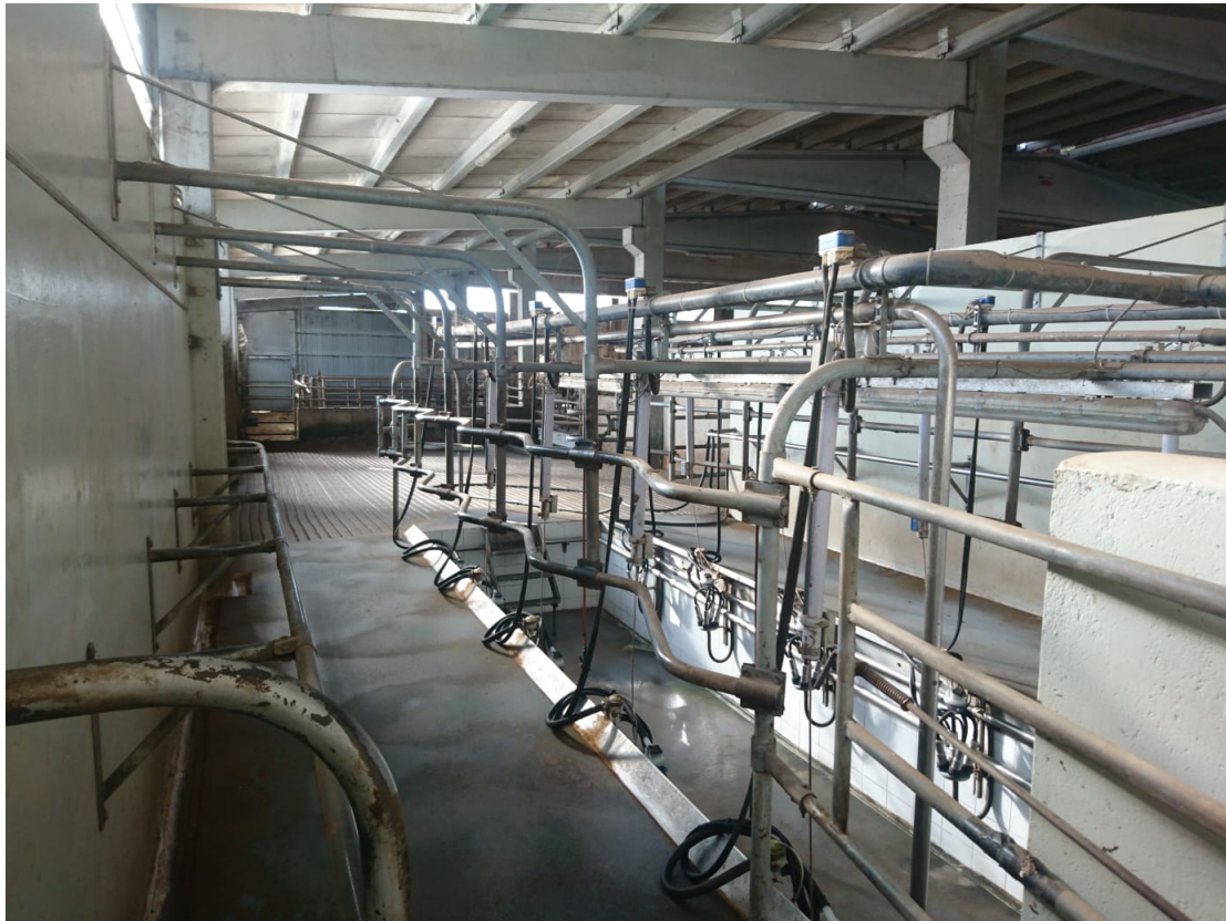
Figura 4.1.0.4 – Sala de ordeño de la explotación
