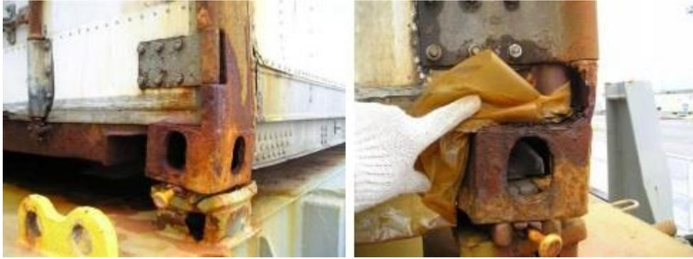
*Figura 7: Daños en un contenedor provocados por la corrosión*
