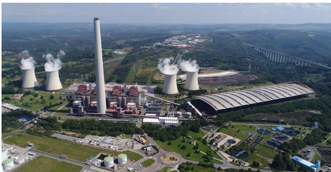
Figura 17. Central Térmica As Pontes.
