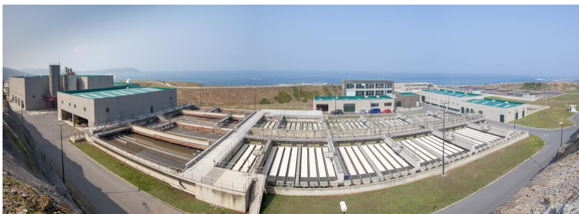
Figura 37. Instalaciones de la EDAR Bens A Coruña.
