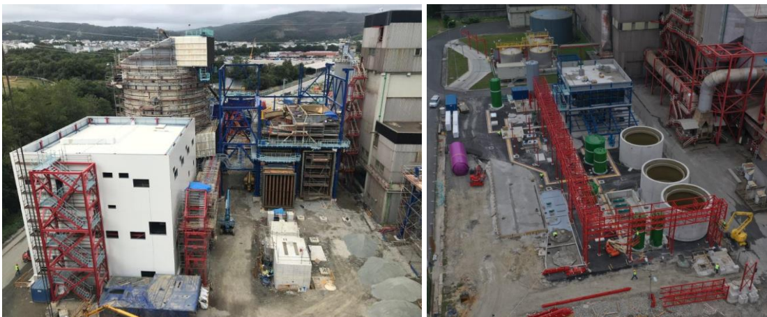
Figura 26. Estado de avance de la FGD y WWTP en julio del 2019.
