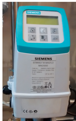
Figura 7.1.2.5 – Caudalímetro
