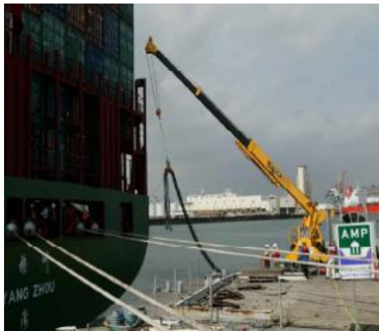
Figura 7.4.1 – Conexión Shore-To-Ship con barcaza Fuente: García, F. [21]
