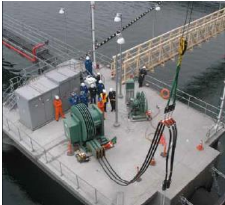
Figura 7.4.4- Conexión Shore-To-Ship integrada en el muelle Fuente: García, F. [21]
