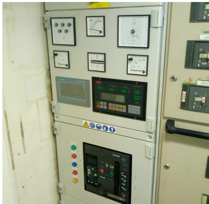
Figura 10.3.2.3 – Cuadro de sincronismo y acoplamiento STS con pantalla táctil
