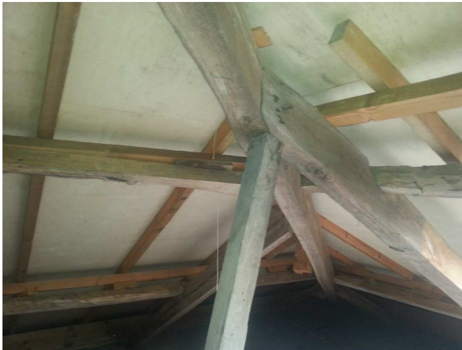
IMAGEN 10: Estructura de madera de cubierta (Fuente: elaboración propia)
