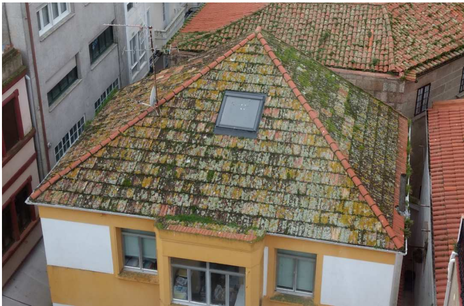
IMAGEN 11: Cubierta de teja cerámica plana a tres aguas. (Fuente: Elaboración propia)
