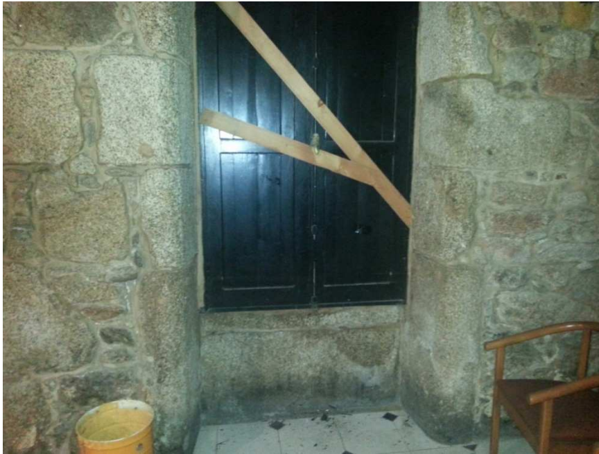
IMAGEN 9: Encuentro de muro de mampostería de granito y ventana con contra de madera, local comercial, planta baja (Fuente: elaboración propia)
