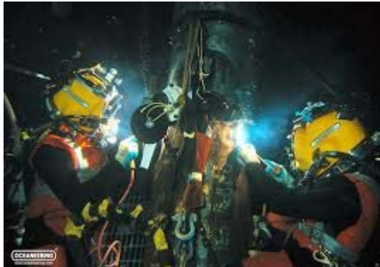
Figura 3.2.1. Buceadores trabajando en saturación. Fuente: Oceaneering.
