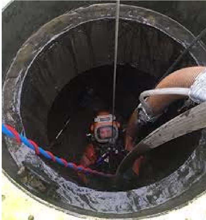
Figura 3.3.7. Buceador dentro de un tanque en ambiente altamente contaminado. Fuente: Tauchunternehmen Wolfgang Dauth.
