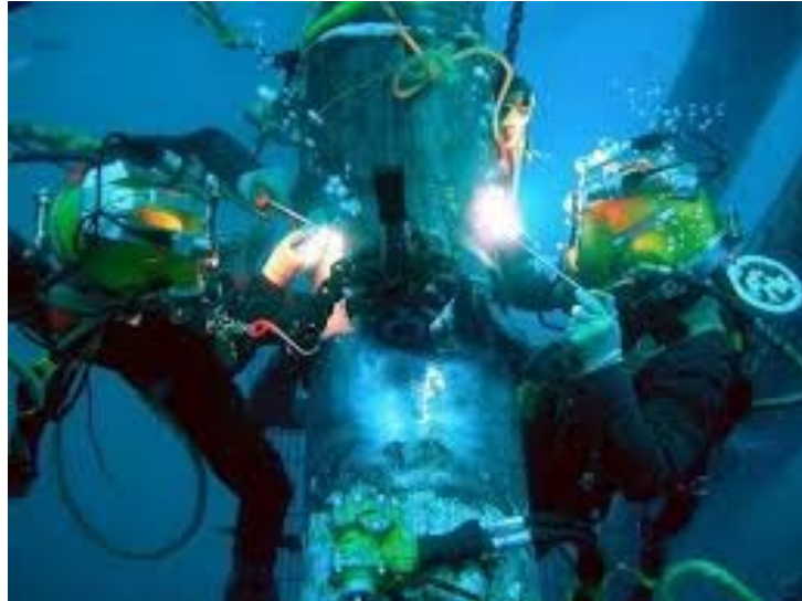
Figura 2.3.1. Buceadores soldando una estructura. Fuente: Oceaneering.
