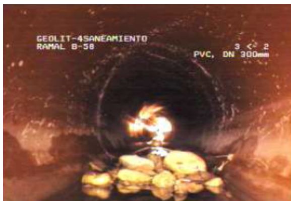
Figura 1: Presencia de obstáculos en colector
