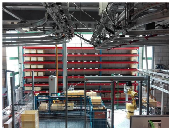
Figura 2: Detalle de sistema: Fondo, almacén transelevador; Techo, almacén aéreo; Dcha., transportador Power&Free; Centro, cinta transportadora dos niveles.
