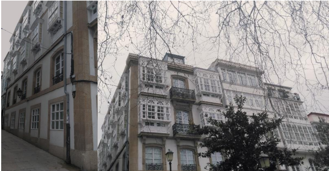
Figura 7. Ejemplo de rehabilitación de un edificio colindante a la plaza de Azcárraga.
