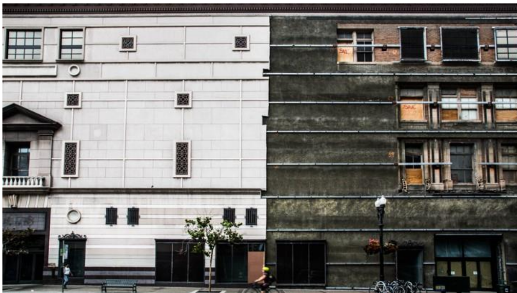
Figura 2. Ejemplo de la “impronta gentrificadora” en un edificio de Brooklyn, Nueva York.
