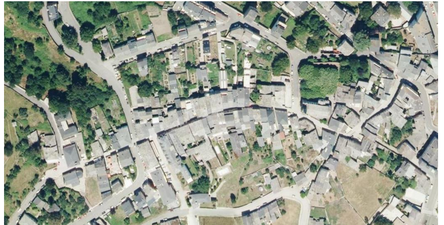
Fig. 85. Vista aérea de la calle Mayor, en la que se aprecian las distintas cubiertas, 2019
