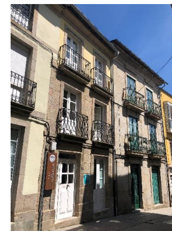
Fig. 68. Nº 52, fachada con mampostería en PB y P1, revestimiento pintado en P2
