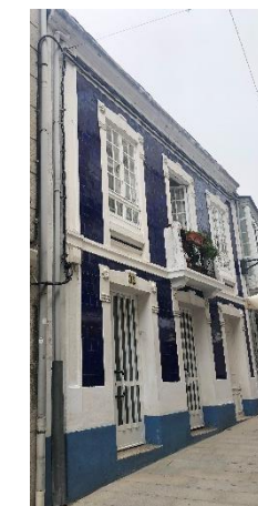
Fig. 69. Nº 32, fachada alicatada
