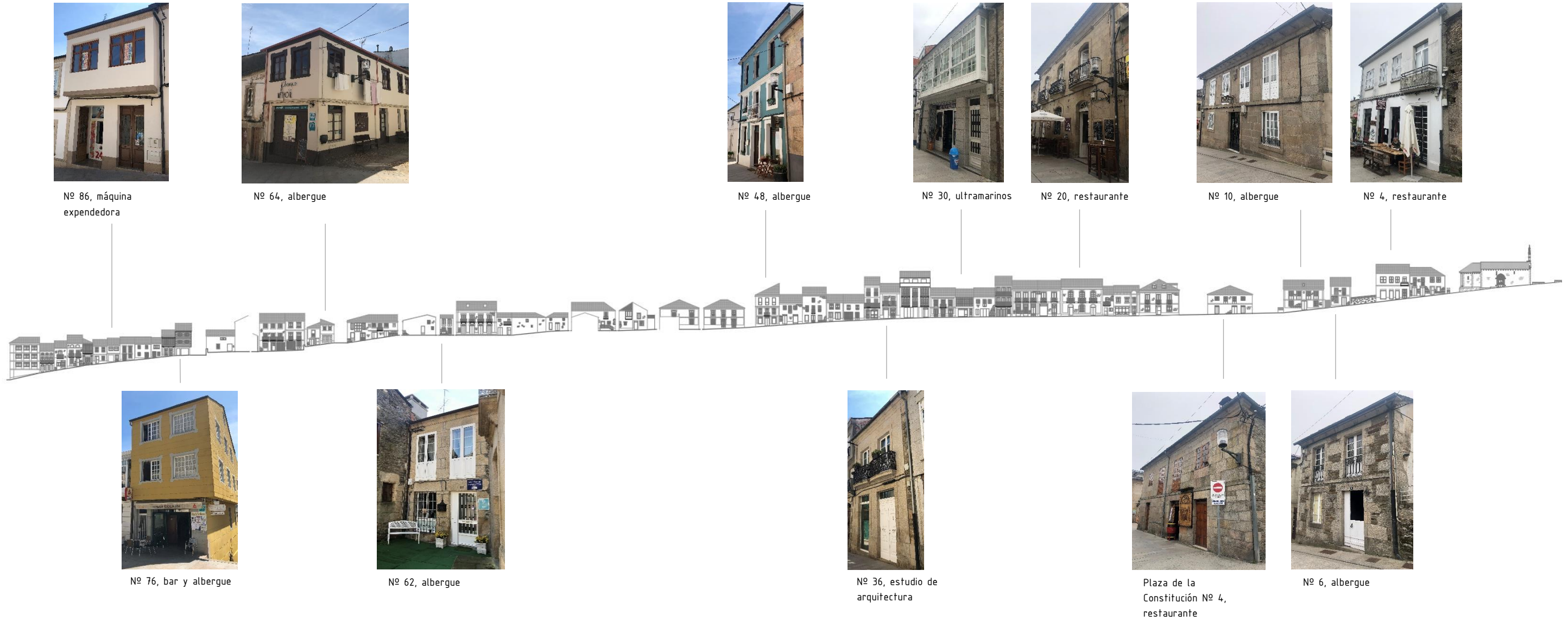
Fig. 61. Alzado del margen derecho de la calle Mayor, caminando desde la iglesia de San Salvador hacia la iglesia de Santa Mariña, con las fotografías de las fachadas de las edificaciones con usos terciarios, 2019
