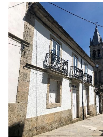
Fig. 70. Nº 63, fachada con revestimiento pintado y sillares para las esquinas / huecos
