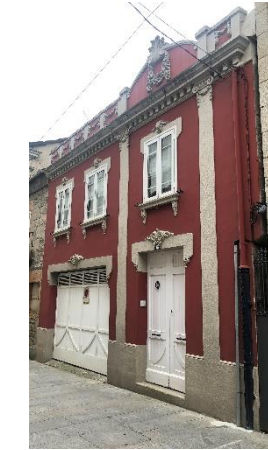
Fig. 66. Nº 16, fachada con revestimiento pintado
