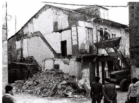
Fig. 15. Demolición de vivienda en el cruce de la calle Mayor con la calle da Calexa, 1982
