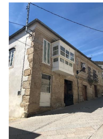
Fig. 71. Nº 64, fachada de sillería
