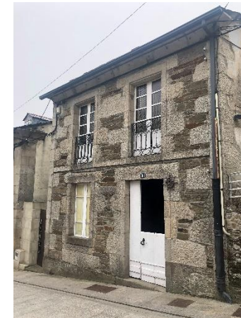
Fig. 64. Nº 8, fachada de mampostería y sillares
