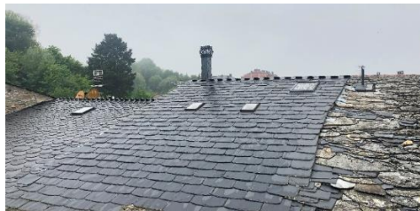
Fig. 82. Cubiertas edificios nº 21, 23 y 25
