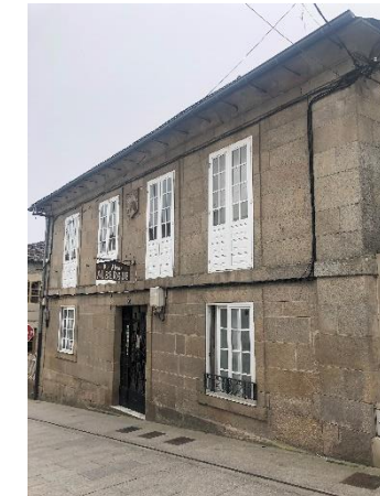
Fig. 65. Nº 10, fachada de sillería
