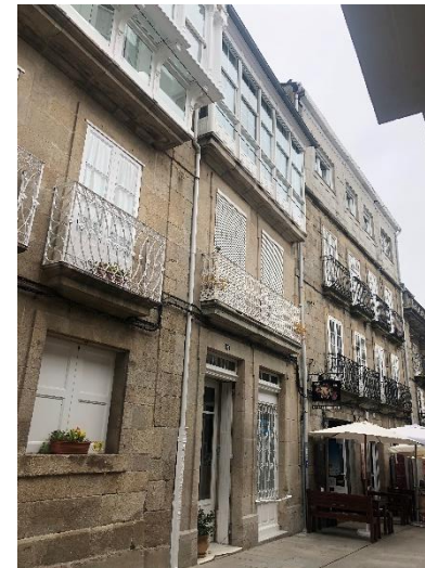
Fig. 90. Vista de la calle Mayor, desde el nº 43, 2019
