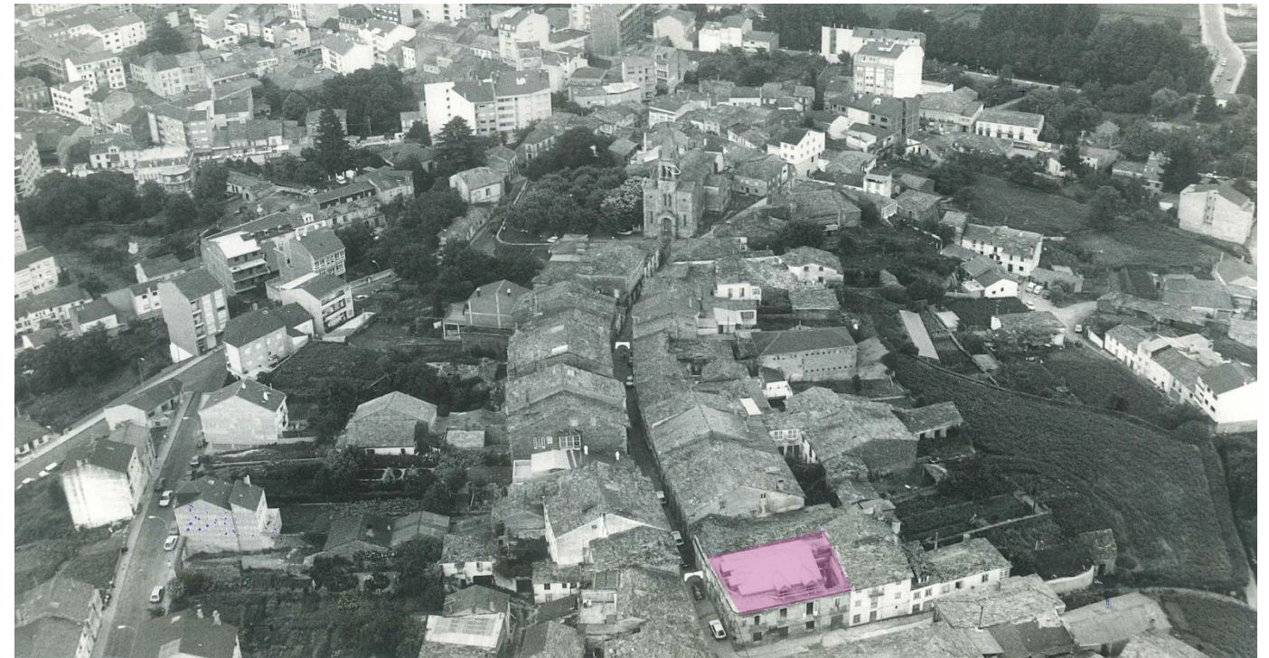
Fig. 29. Foto aérea de la calle Mayor, en la que se ven las obras de rehabilitación de la casa consistorial, hacia 1988
