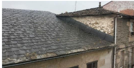
Fig. 83. Cubiertas edificios nº 46 y 44
