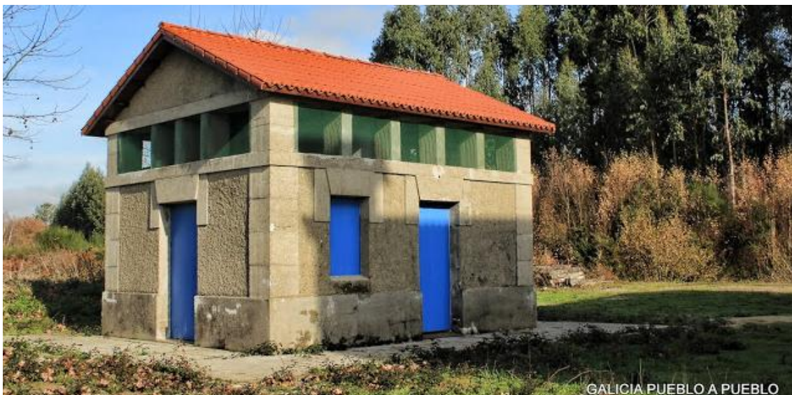
Edificio de aseos. Fachadas Oeste y Sur. Fuente ( https://galiciapuebloapueblo.blogspot.com )
