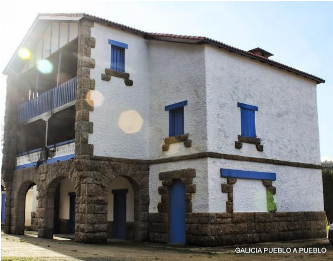
Edificio principal. Fachadas Norte y Este (Fuente https://galiciapuebloapueblo.blogspot.com )
