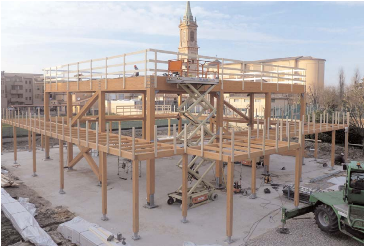
Fig. 06a y 06b. Barbara Fiorini, Iglesia provisional, Renazzo (Italia), 2012; el proceso de montaje. Fig. 07. El antiguo campanario visto desde la nueva iglesia.
