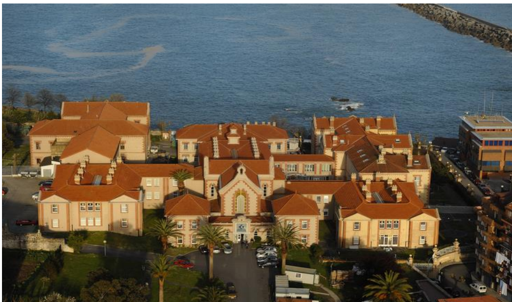
Ilustración 2. Hospital de Bermeo, Vizcaya
