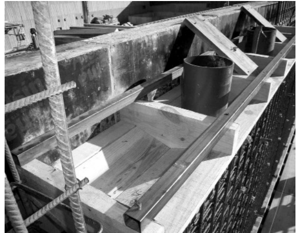
Fig. 18. Detalle de la coronación de los muros de hormigón armado.
