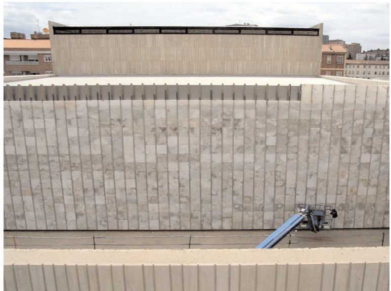
Fig. 21. Montaje del muro de alabastro (2007).
