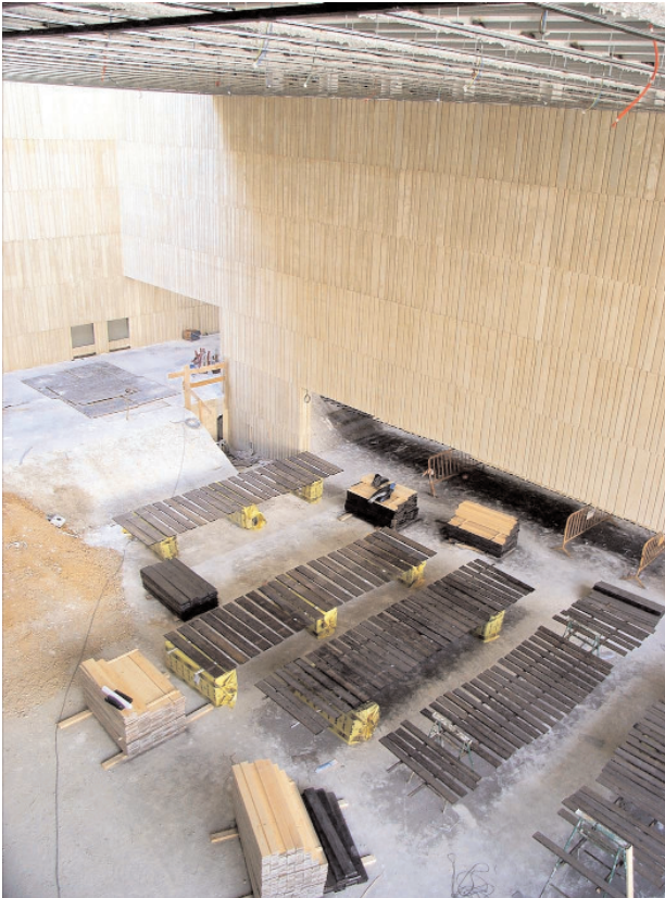
Fig. 20. La nave de la iglesia, durante el montaje del falso techo de madera (2007).
