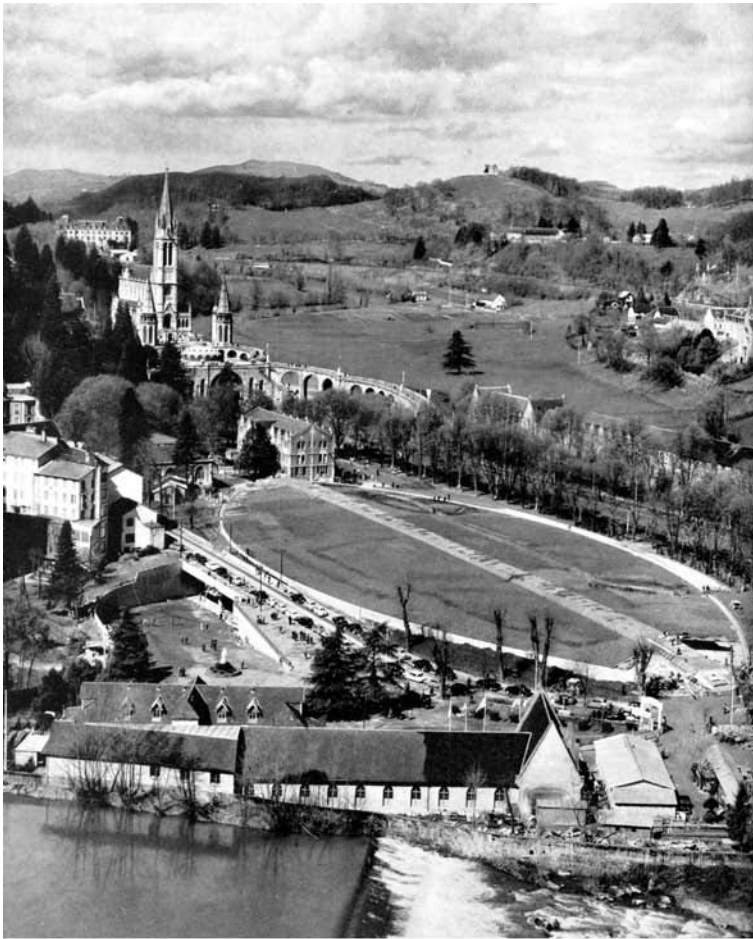
Pierre Vago, Pierre Pinsard y André Le Donné, Basílica subterránea de San Pio X, Lourdes (Francia), 1952/57.
