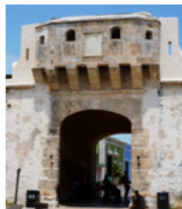
Fig. 5. Puerta de Tierra
