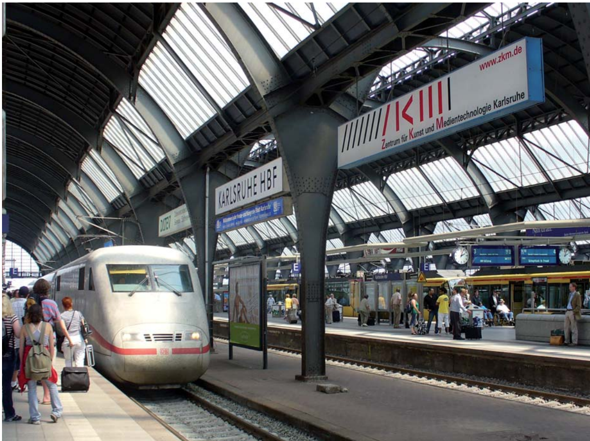
Estación central de Karlsruhe con vehículo ICE y tranvitrén al fondo. Autor: Axel Kühn.
