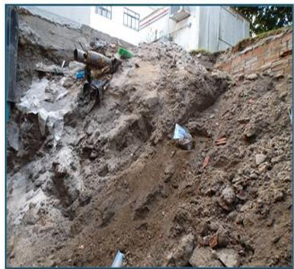
Foto 4. Presencia de tuberías y residuos.
