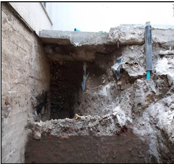
Foto 3. Vista de los antiguos piezómetros.
