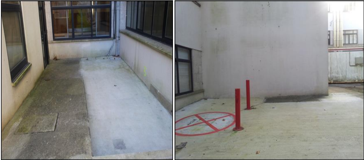
Foto 6. Zona de actuación donde se localizaba el piezómetro. Foto 7. Zona piezómetro P-1 y arqueta de pozo de registro.
