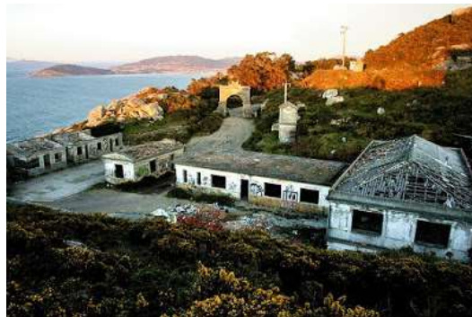
Foto 5: estado actual de las instalaciones militares
