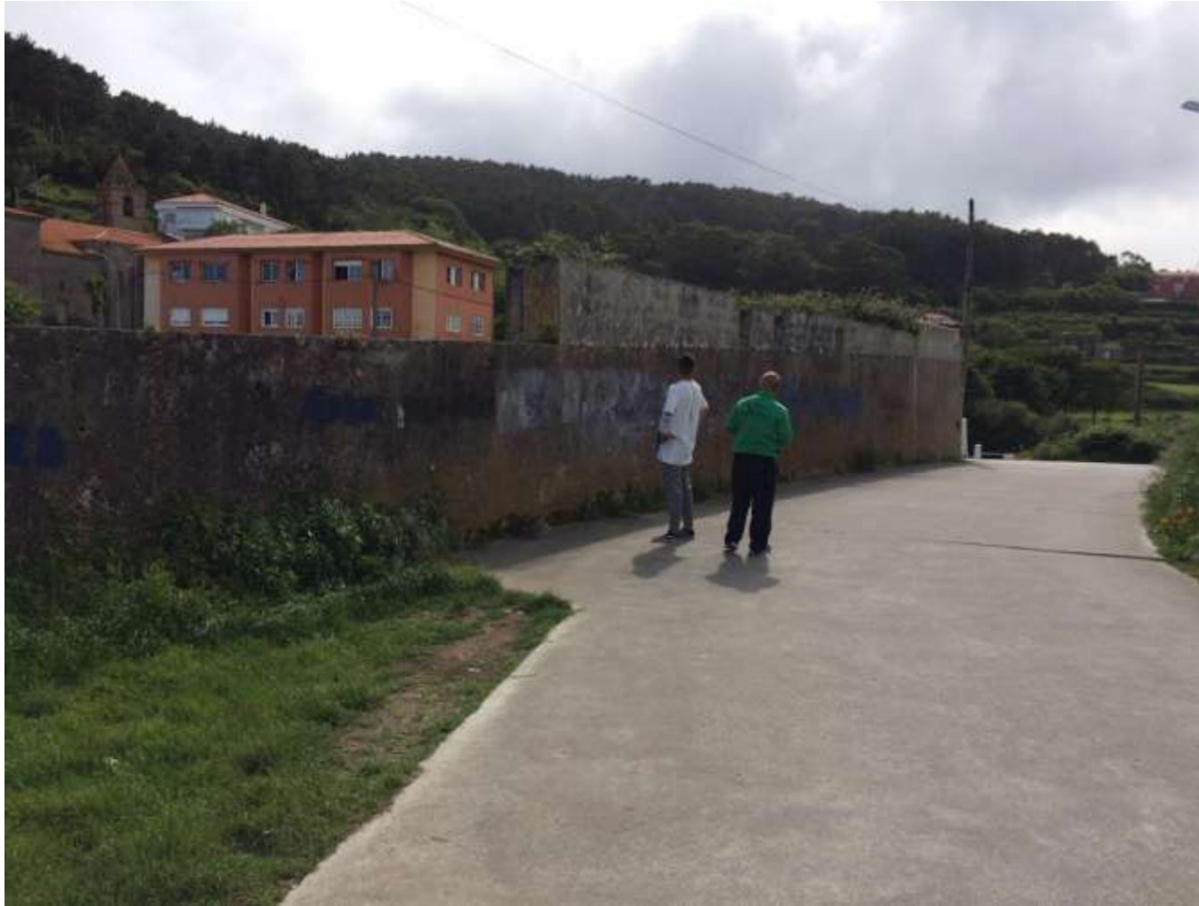
Imagen nº11: Muro que rodea la zona norte del área recreativa y pista de acceso a la misma, este vial es de sentido único, la foto está tomada en sentido de avance, en el proyecto se plantea la demolición de esta parte del muro para ampliar la pista y de esta manera conseguir dos sentidos de circulación para dar acceso al aparcamiento nº2
