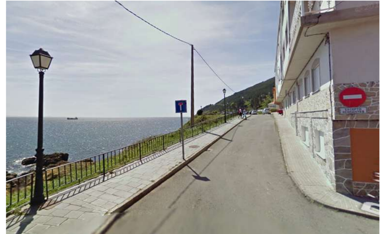
Imagen nº4: En esta fotografía se observa la señal de entrada prohibida excepto residentes y la de camino sin salida en este tramo hay dos sentidos de circulación y la acera de la derecha en ciertos puntos no cumple la normativa de accesibilidad.
