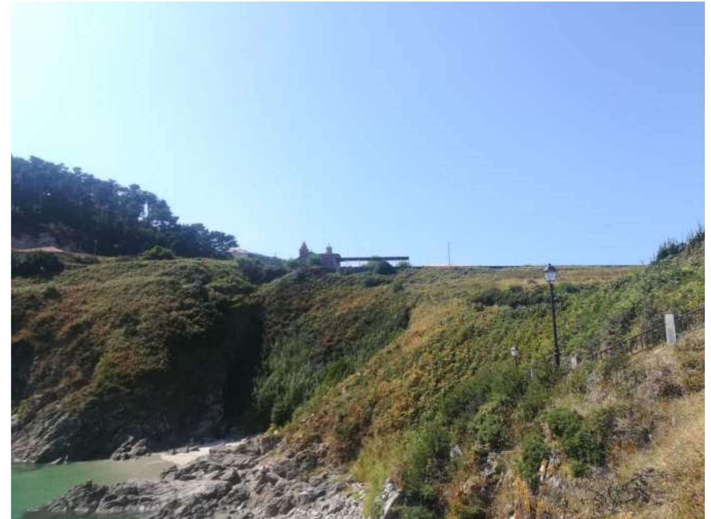
Imagen nº8: En esta imagen se observan las escaleras de acceso a la playa, el tramo por donde discurrirá el nuevo trazado y la iglesia al fondo, detrás de la pérgola del área recreativa.
