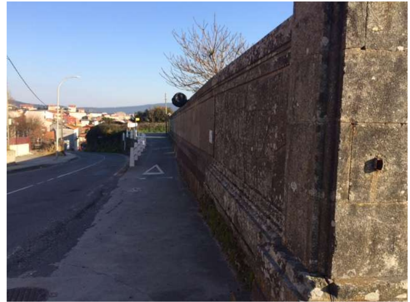
Imagen nº16: Imagen de la pista que rodea el muro de la pista y el vial de sentido único, a la izquierda la carretera AC-445, al fondo el casco urbano del pueblo de Finisterre.
